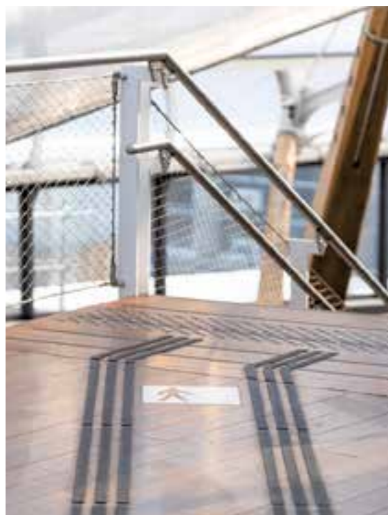
↳ En haut et en bas des escaliers, une bande contrastée permet de mieux appréhender le départ et l'arrivée..
