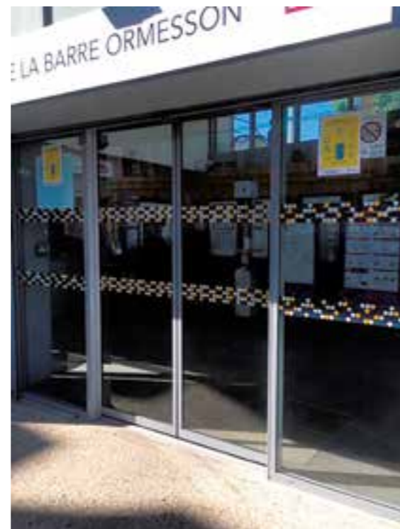
↳ Un système de marquage, appelé vitrophanie, est installé sur les parois vitrées pour éviter les heurts sur la surface transparente.
