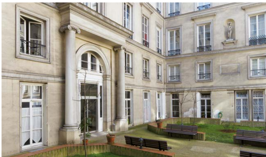
Résidence-apartement Les Maréchaux, 15 rue Richer - 75009
