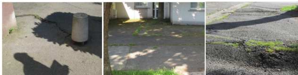
Exemples de problèmes rencontrés sur le secteur Cœur de Cleunay pouvant handicaper les personnes âgées : crevasses, bosses, obstacles.
